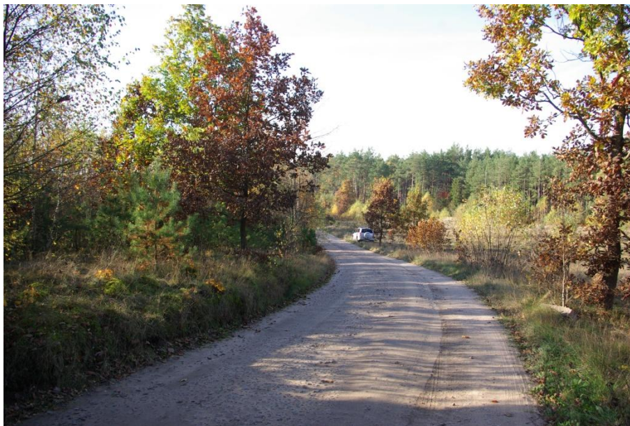
Fot. 1 Droga gruntowa rozdzielająca pola eksploatacyjne A i B
