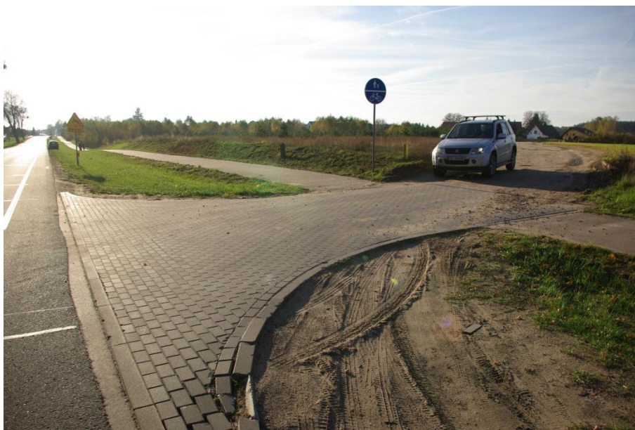
Fot. 6 Włączenie do drogi krajowej (niedostosowane do ruchu ciężkiego)
